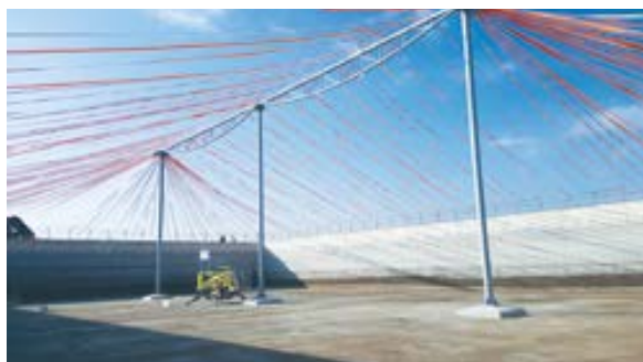
Realizzazione su vasca rettangolare di una copertura antiemissione
