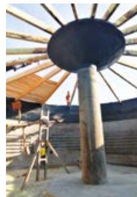
Ricostruzione sottostruttura in legno di un digestore
