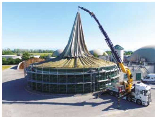
Sostituzione del telo gasometrico di un impianto di biogas
